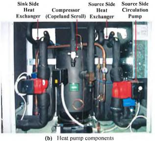
FIGURE 3.13 SOLTERRA 500 HEAT PUMP INSTALLATION COMPONENTS.
